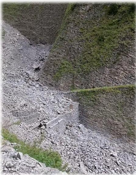
Dadurch wird verhindert, dass die losen Steine talwärts transportiert werden (durch Schnee oder Wasser). Die Terrassierung reduziert das Schneegleiten und bildet Auffangräume für weiter oben abrollendes Material. Je nach Beschaffenheit der Oberfläche müssen zusätzlich Erosionsschutznetze eingebaut werden.
